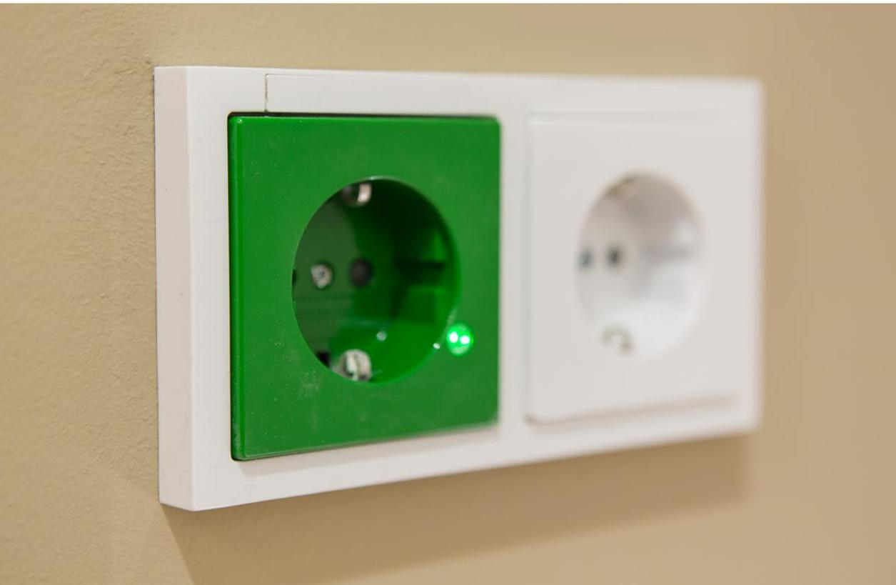
Die farblich abgesetzte Steckdose kann geschaltet werden (Schalter, General-aus-Schalter, etc.)
